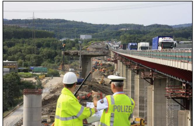
Als große Mammutaufgabe zählt der sechsstreifige Ausbau der Autobahn 45. Auf dem Streckenabschnitt zwischen dem Autobahnkreuz Dortmund-Nordwest und der hessischen Landesgrenze werden auf ca. 125 km insgesamt 38 Großbrücken unter fließendem Verkehr neu gebaut.
